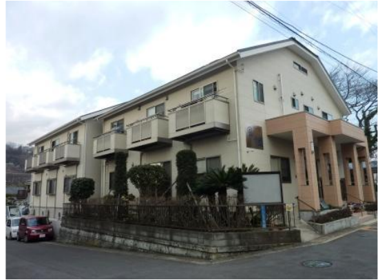
小規模多機能居宅照護服務（小多機）實例照片：一、二樓總共有七間個人房。原來地方的一樓目前做為小多機的設施空間。
